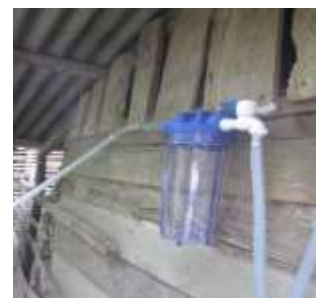
Gambar 9. Water trap sebagai perangkap H 2 O
