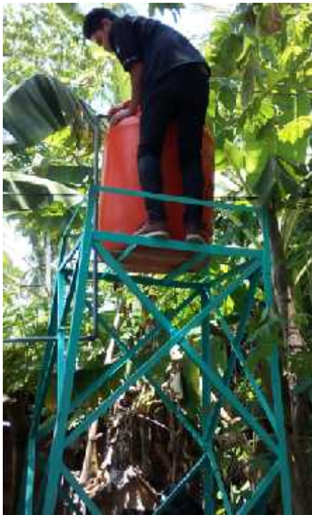
Gambar 7. Penempatan tangki di atas tower.
