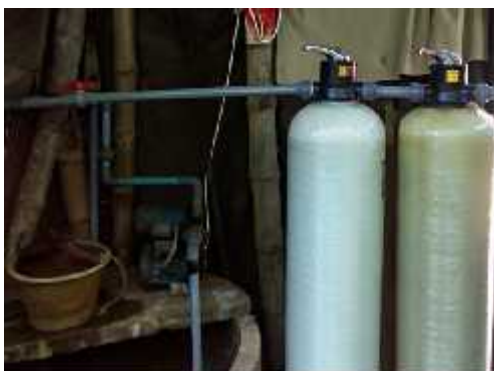
Gambar 8. Instalasi pipa dari dalam sumur ke media penyaring.
