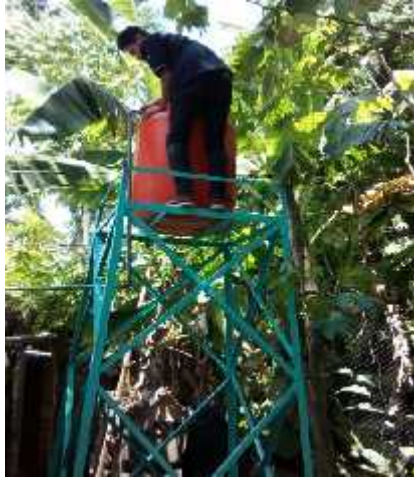
Gambar 6. Kontruksi tower air hasil kerja peserta training langsung diaplikasikan dilapangan.
